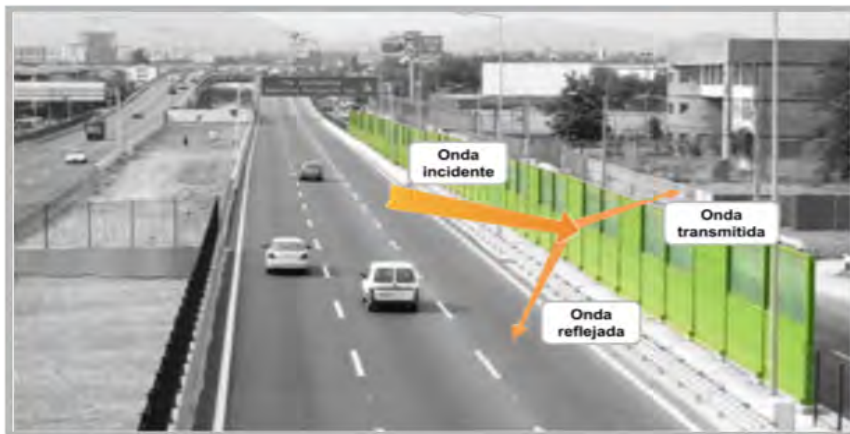
Barreras Acústicas Autopista Américo Vespucio Sur, Sector Av. Grecia
