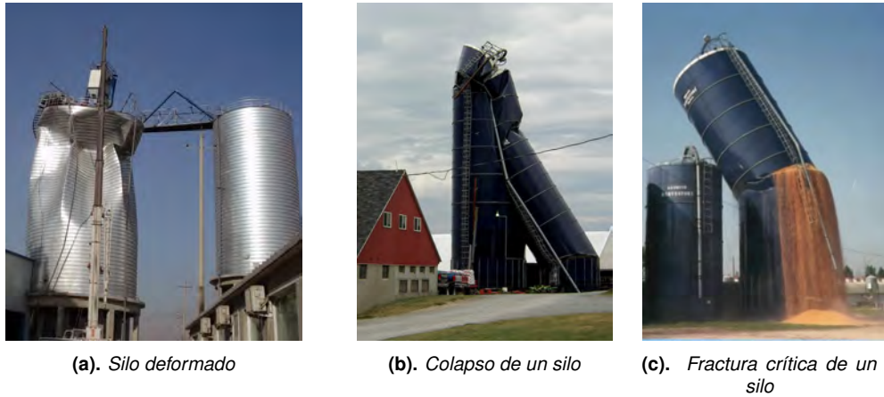
Figura 2. Fallas encontradas en silos en distintas aplicaciones de la industria.
