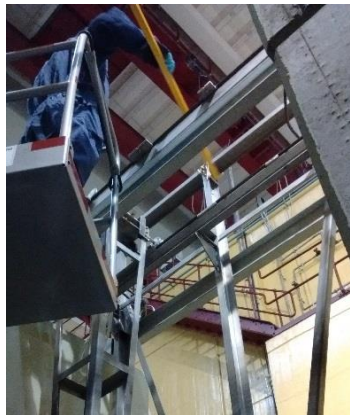
Figura 78: Verificación de la nivelación del montaje en la posición de mantenimiento.
