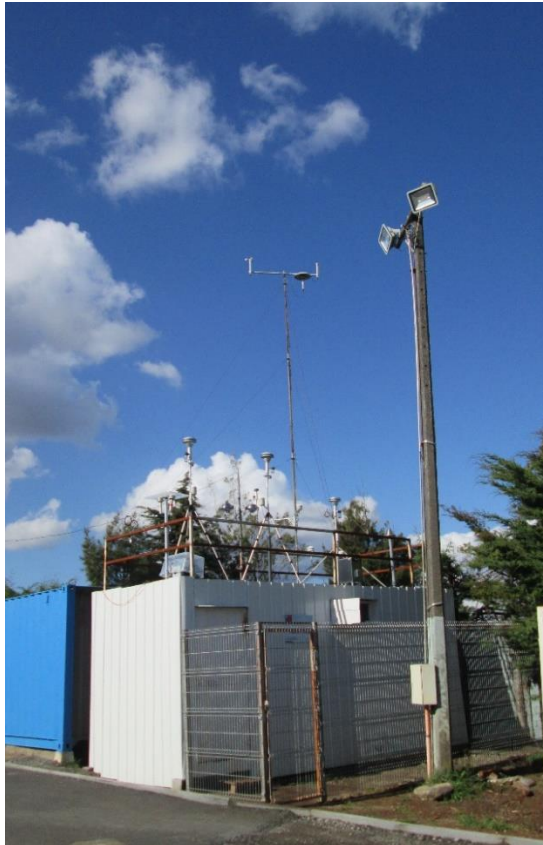
Ilustración 12: Estación Kingston College, se observa el contenedor utilizado y sobre él equipos de monitoreo de calidad del aire junto con sensores de variables meteorológicas,
